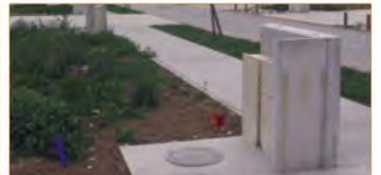
L'intégration des coffrets dans un petit muret construit à l'identique sur l'ensemble de l'opération permet d'en réduire l'impact.
