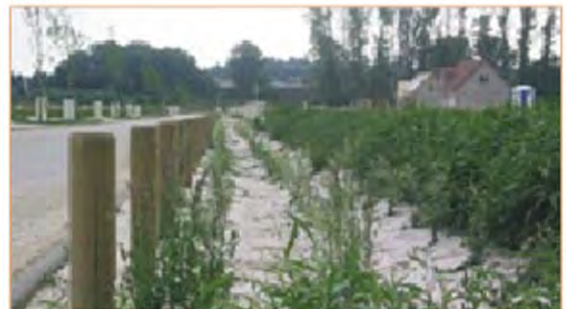
Une noue collectrice des eaux pluviales.
