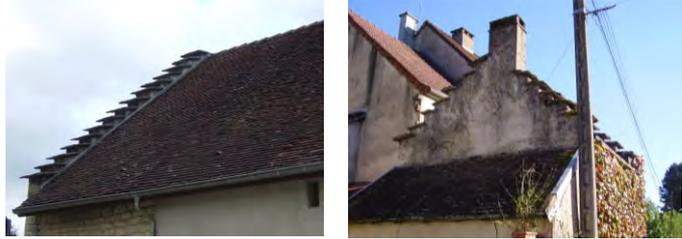
Le matériau utilisé pour les murs est le moellon de pierre calcaire presque systématiquement recouvert d'un enduit à la chaux teintée par des sables extraits dans les environs. Aucune façade n'est bardée.
