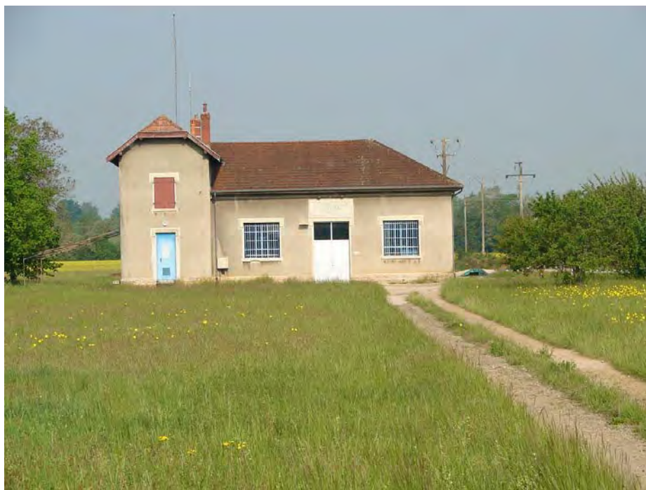
La station de pompage de Trenal
