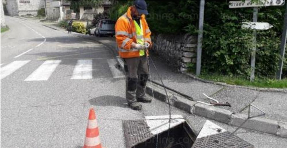
*Les travaux en cours à Creys. C'est sur ce type de terminaison que les brins du câble principal sont répartis avant d'être acheminés un par un vers les utilisateurs.*
