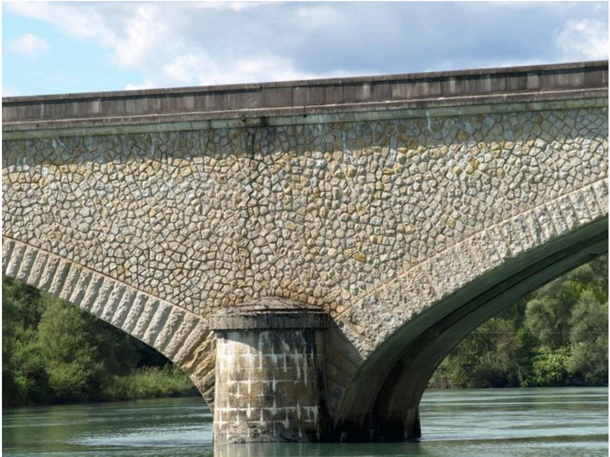
Pile, face amont (depuis la rive droite)
