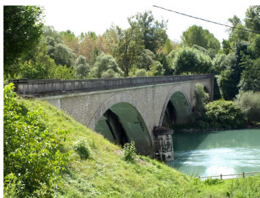
Vue latérale, face aval (depuis la rive droite) Phot. J. Marasi
