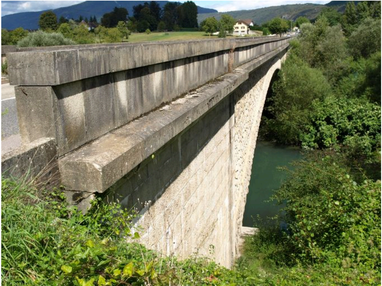
Parapet, vue partielle amont (depuis la rive gauche)
