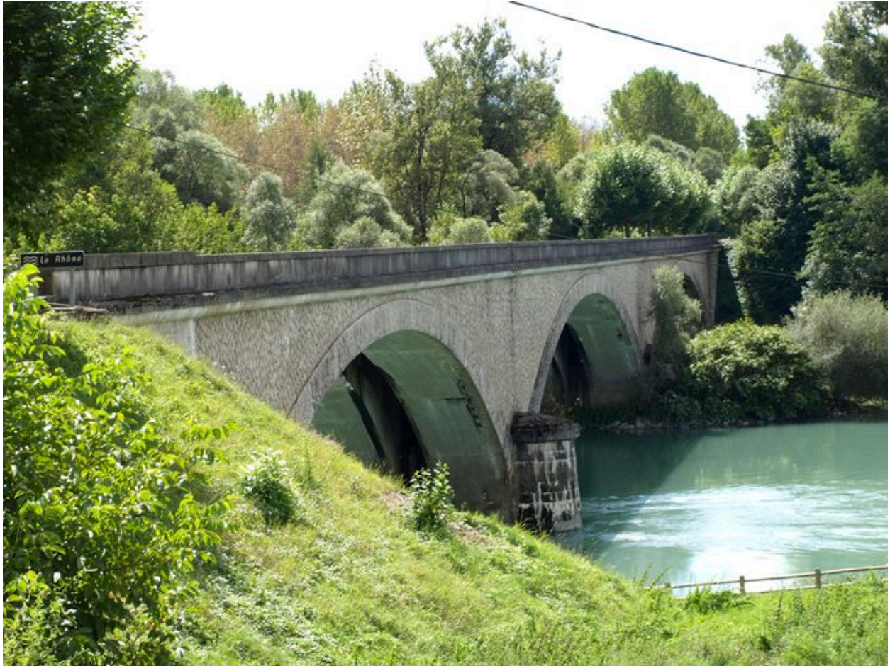
Vue latérale, face aval (depuis la rive droite)
