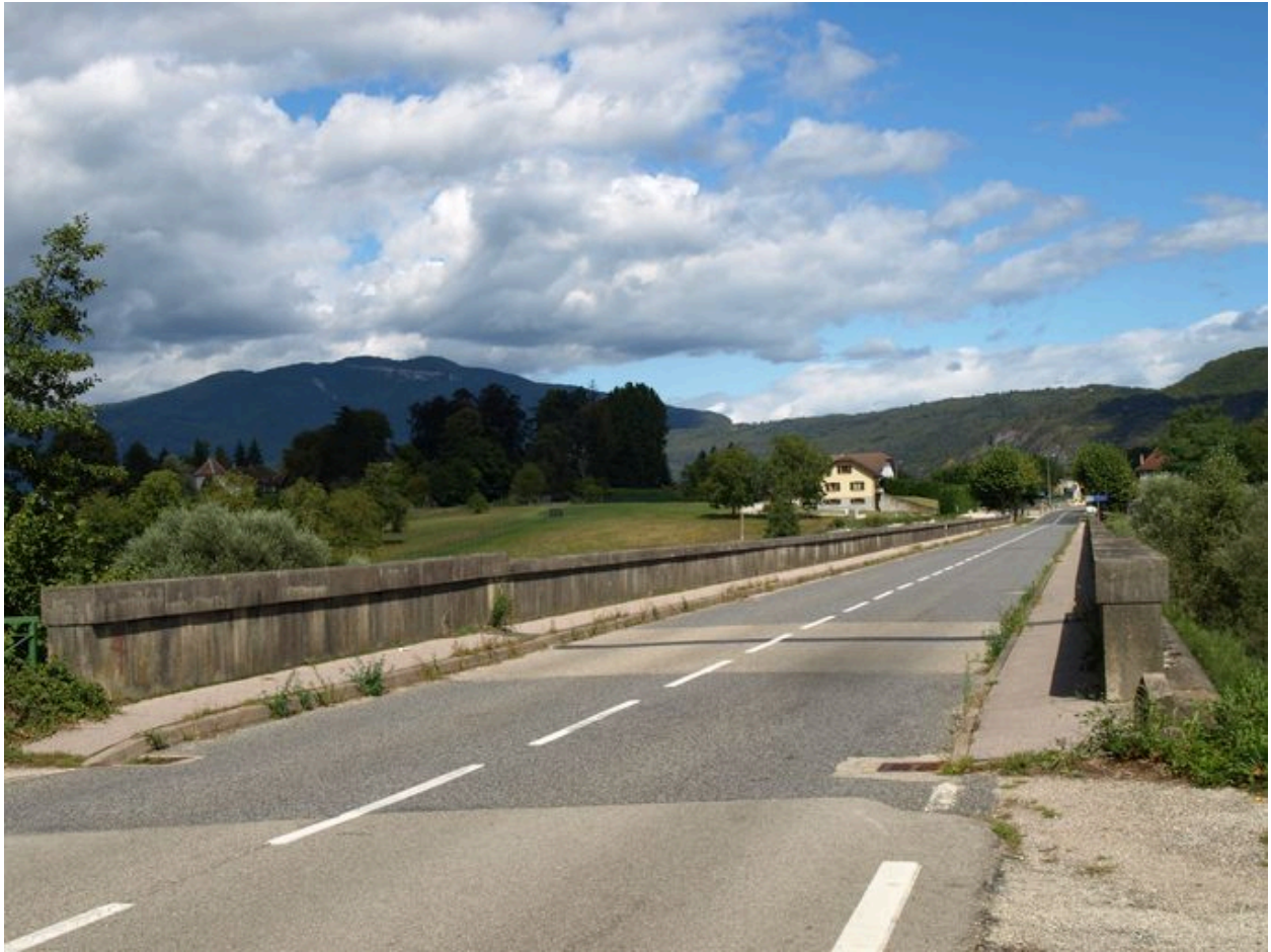
Chaussée (depuis la rive gauche)
