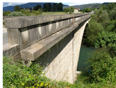
Parapet, vue partielle amont (depuis la rive gauche) Phot. J. Marasi
