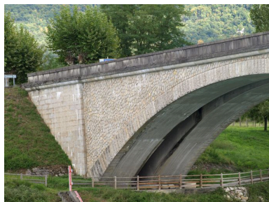
Culée de la rive gauche, face aval Phot. J. Marasi IVR82_20100100247NUCA
