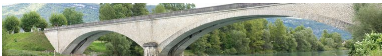
Vue panoramique, face aval (depuis la rive gauche)
