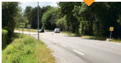
Travaux rue de la Bastille
