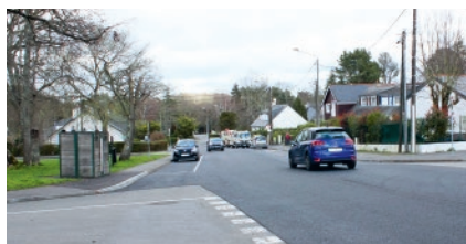
Travaux rue du Cens
