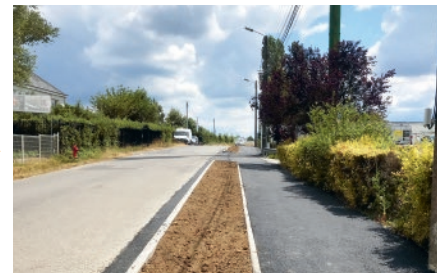
Travaux route de la Hubonnière
