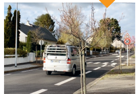
Travaux rue du Bois Colin
