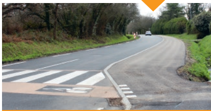
Travaux route de Brimberne
