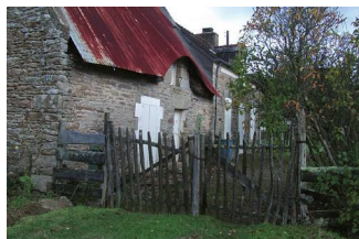
bâti ancien structurant
