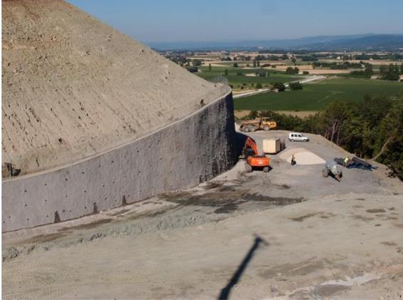
Depuis les travaux de drainage de la plate-forme dans la plaine effectués au printemps, cette zone est contrôlée régulièrement par l'entreprise Berthouly pour suivre les tassements des remblais. Les dernières mesures montrent la stabilisation des remblais, ce qui a permis la reprise des travaux de terrassement. L'entreprise Eiffage interviendra ensuite pour réaliser les couches de roulement dans la plaine.
