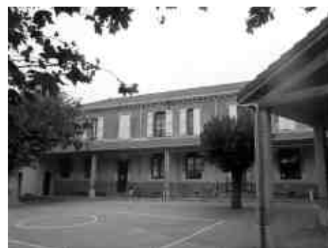
L'école et sa toiture flambant neuve
