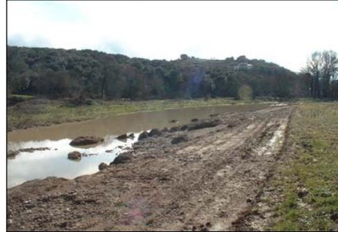
**Creusement d'un lit de crue parallèle au cours de l'Avène, dont on aperçoit la ripisylve à l'arrière plan**
