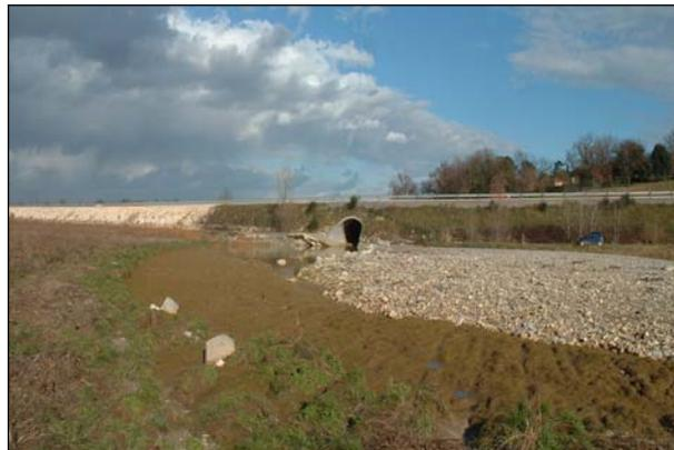
**Remblai de la RN 106 au droit du Cheval Vert. Partie érodée et enrochée à gauche, surcreusement et dépôts grossiers à l'aval de la traversée**
