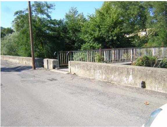
*Vue du mur de quai en bordure du Gardon d'Alès sur la commune des Salles du Gardon : Ouvrage présentant des ouvertures dans sa structure (fente de dilatation, ouvrage discontinu, trou d'évacuation ...) au-delà des risques de brèche comme ce fut observé sur la traversée d'Alès (débordement du Grabieux avec retour en lit du Gardon ayant entraîné une brèche dans le mur de quai lors de la crue de septembre 2002*
