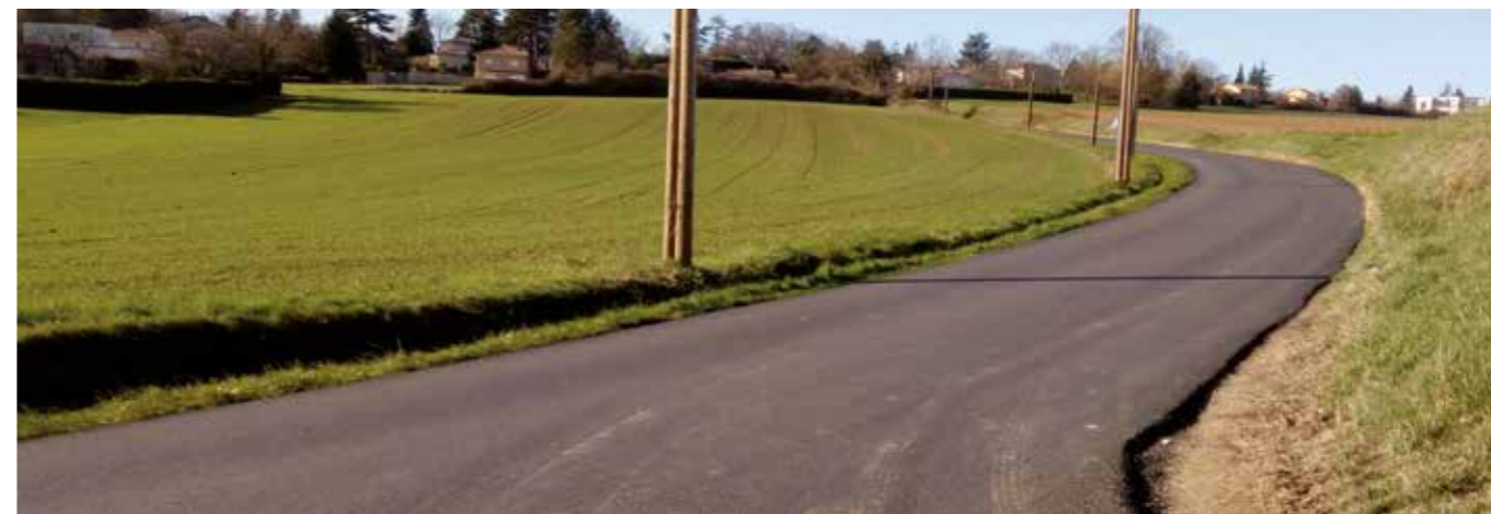
Revêtement chemin du Vieux-Vaugris
