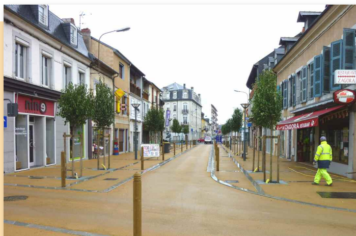
A l'achèvement des travaux
