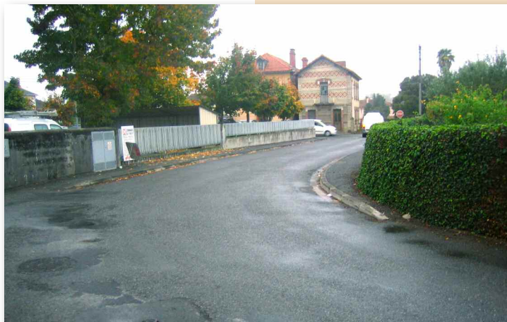
Avant les travaux
