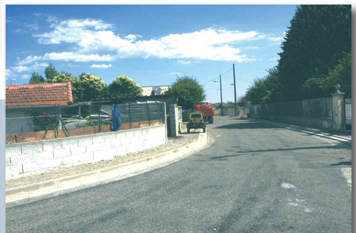
Pendant les travaux
