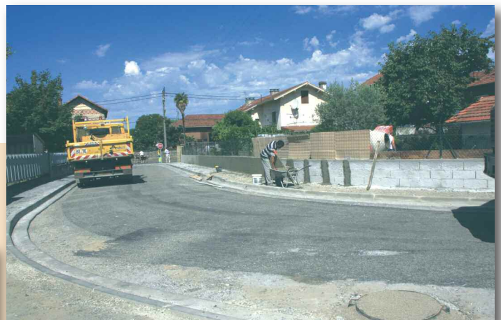
Pendant les travaux
