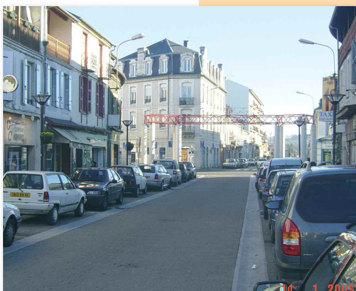
Avant la démolition du portique
