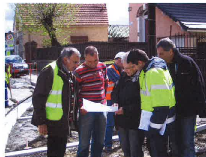
Pierre FAURE, 1er Adjoint, lors d'une réunion de chantier.
