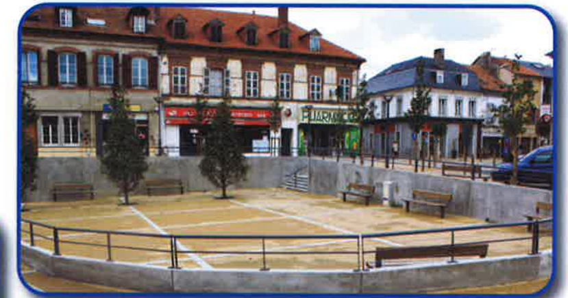
Campagne de réfection des trottoirs en 2009
