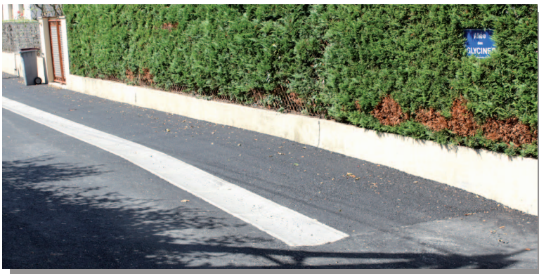
Ci-dessus : les allées des Glycines et des Sauges pendant et après les travaux.
