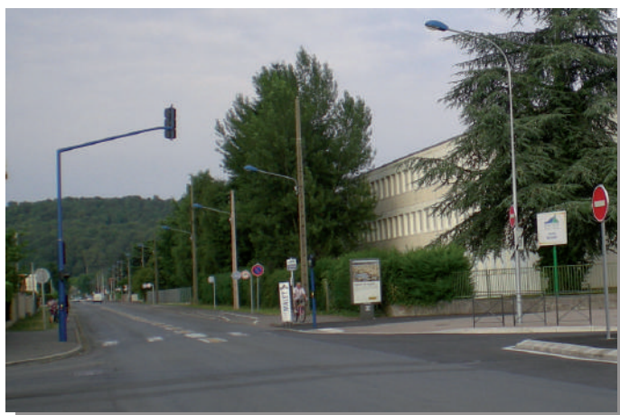
L'Avenue des Sports avant les travaux.
