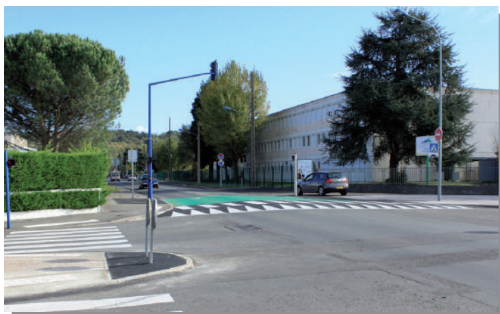
L'Avenue des Sports, après la mise en place du plateau traversant.
