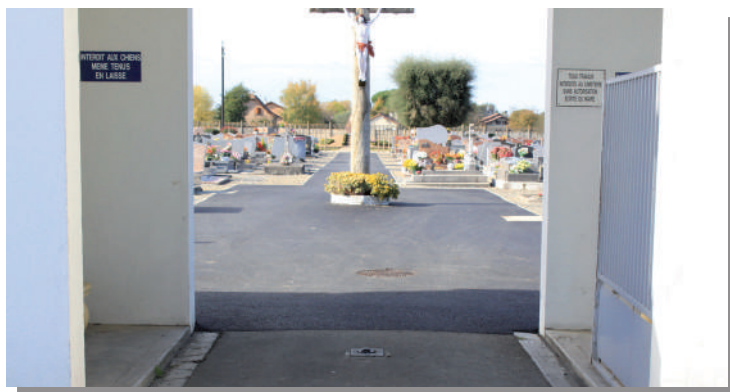
L'entrée du Cimetière Nord avec son allée principale.
