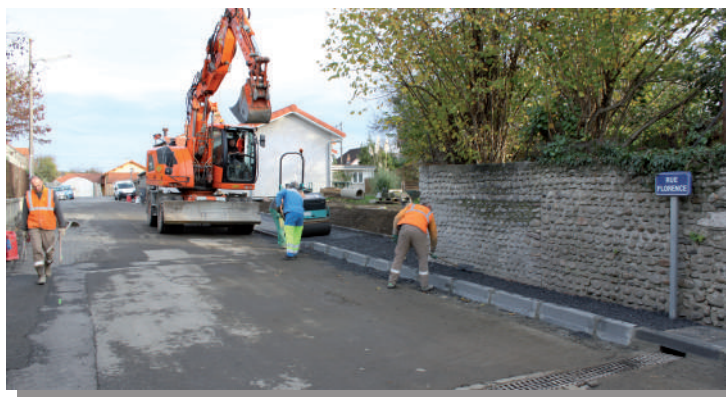
Ci-dessus, la rue Florence, avant et pendant les travaux.
