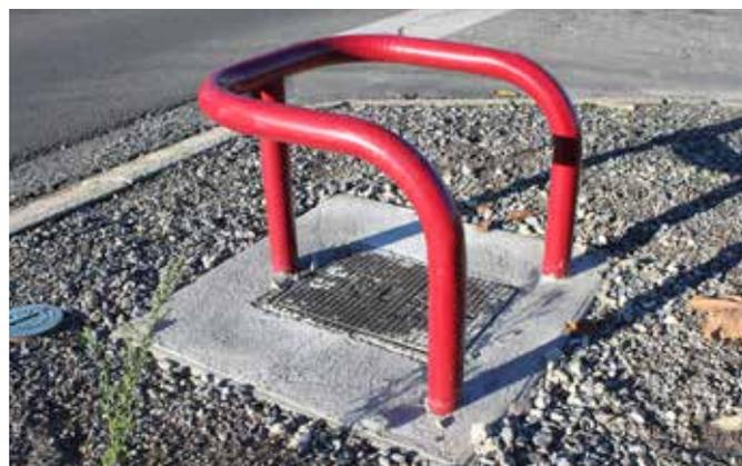
Vétustes ou dégradés par des actes d'incivilité, les poteaux d'incendie font l'objet d'un programme de remplacement. Les nouveaux modèles, enterrés et protégés par un arceau rouge, seront plus robustes et moins sujets aux actes malveillants. La généralisation de ces bouches à incendie permettra de sécuriser les interventions des agents des services de secours.
