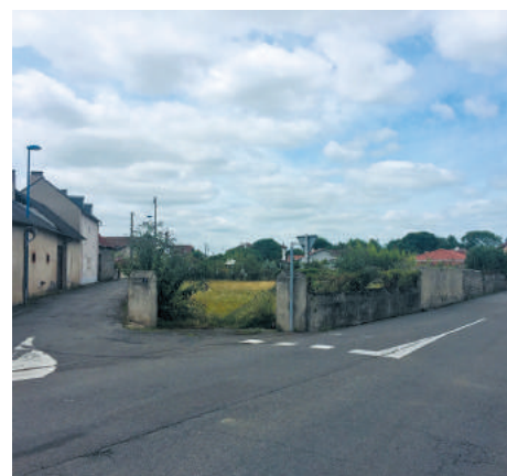
Le carrefour des rues Marcel Sembat et Jules Guesde avant travaux (août 2019).
