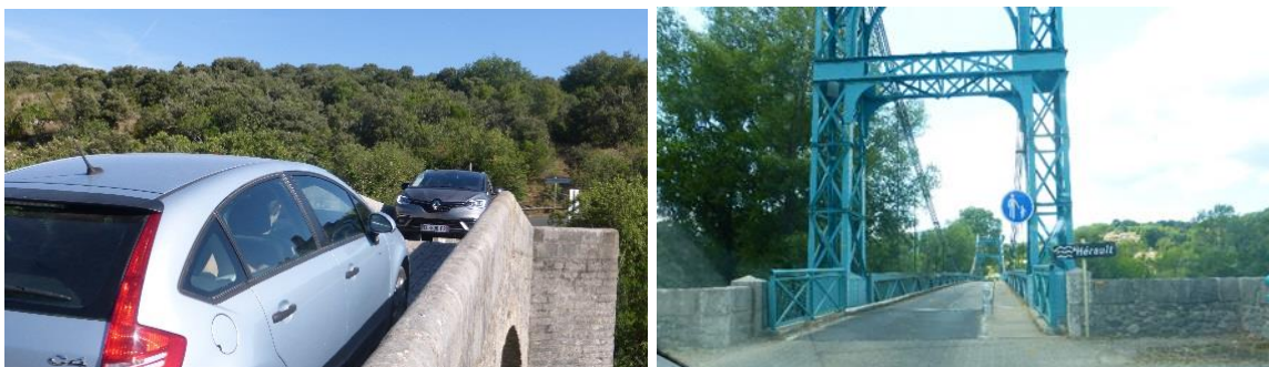
Pont de Saint-Etienne d'Issensac et Pont de Saint-Bauzille-de-Putois
