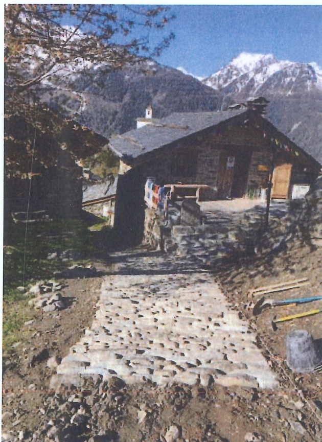
Pavage des ruelles du Châtelard.
