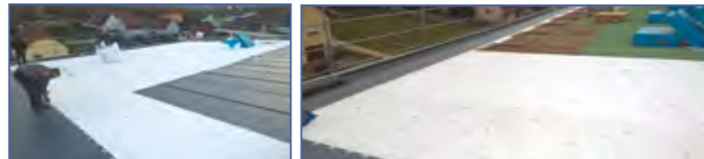
Etat des salles Mermoz après travaux
