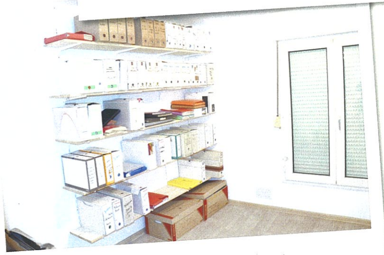
Travaux à la mairie : après ! Les archives ont trouvé place à l'étage.
