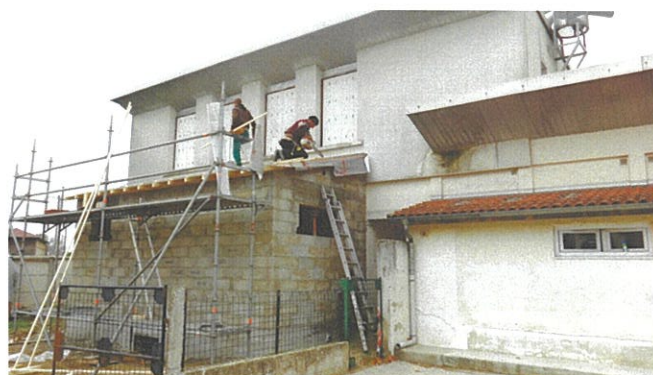
Travaux à la salle de « l'ancienne mairie »
