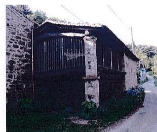
Exemple de débord de toiture et lames fixes
