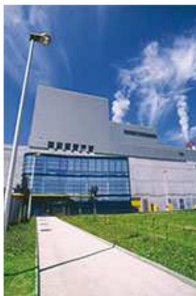
Chaque année, l'usine produit 40 000 MWh d'électricité et 58 000 MWh de chaleur sous forme de vapeur. **En 2018, la performance énergétique de l'UIOM a été de 65,15%, valeur permettant de la qualifier d'unité de valorisation énergétique.**
