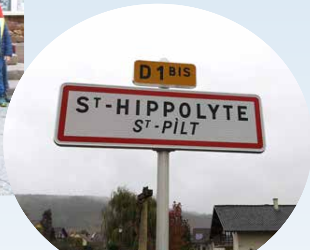
Installation de nouveaux panneaux d'entrée de village en octobre
