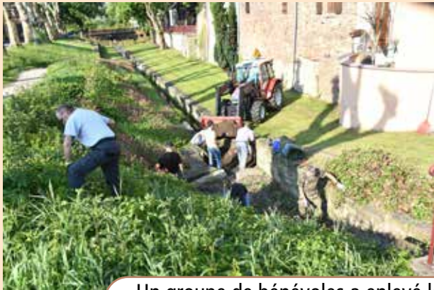
Un groupe de bénévoles a enlevé le sable du dessableur de la Wesch et nettoyé les contours du canal avec l'aide de Michel et de son tracteur.
