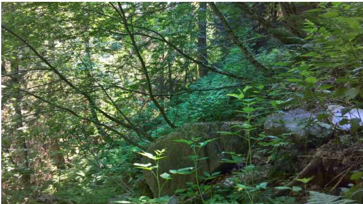
Photo 2 : « tablier d'éboulis surplombant le captage du Rocher du Mont et montrant de surcroît une mauvaise stabilité.
