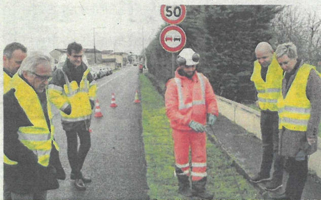
Un branchement fait sur Puisseguin en 2017. ARCHIVES « SUD OUEST »
