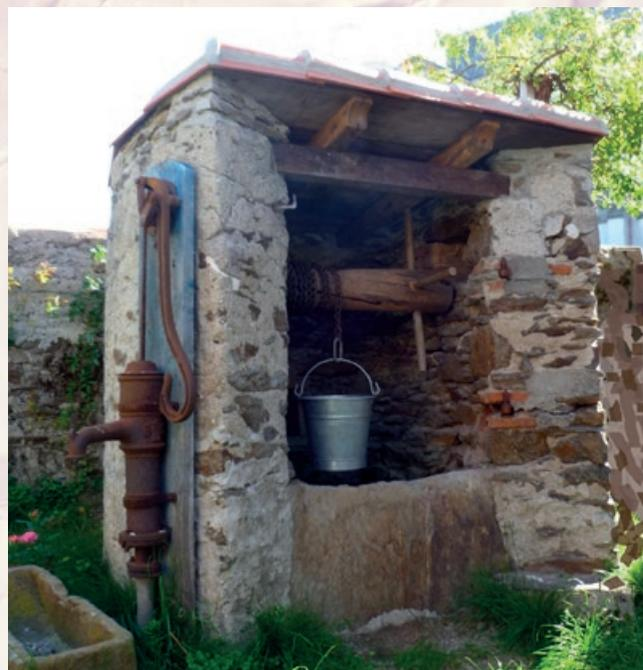
en charpente bois, avec voliges et couverture en « tige de botte ». Une pompe manuelle de la fin des années 50 facilitait le puisage.
