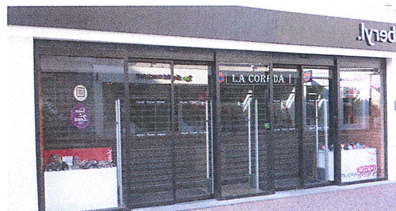
Caisson non apparent en façade (saillie intérieure).
