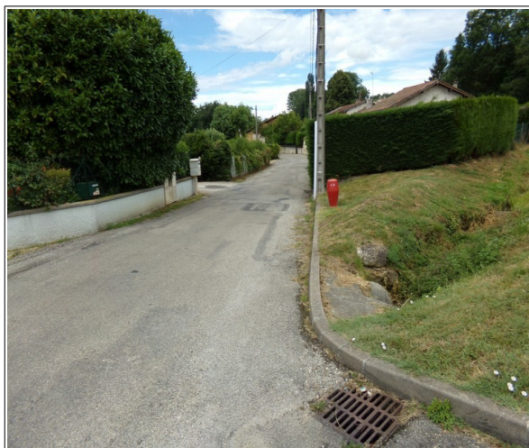
Figure 3.11: franchissement du chemin du Bourg par le chenal du ruisseau du Biel.
