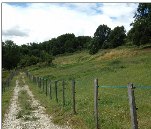
Figure 3.20: zone d'instabilité possible (fluage) au lieu-dit Pavassière (secteur proche d'un captage).
