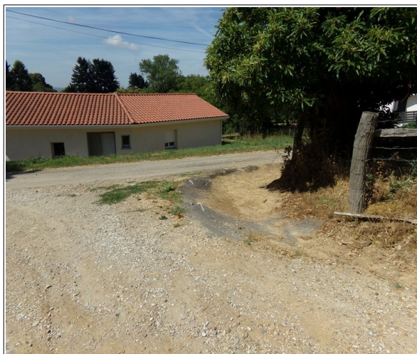
Figure 3.17: profilage en bordure du chemin de La Ratissière pour contenir des ruissellements au niveau du hameau de Notre-Dame.
