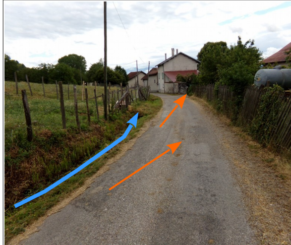
Figure 3.8: ruisseau du Biel bordant la rue de l'Eglise. On notera son lit étroit. Le ruisseau peut déborder sur la route et en direction de la ferme en arrière plan.
