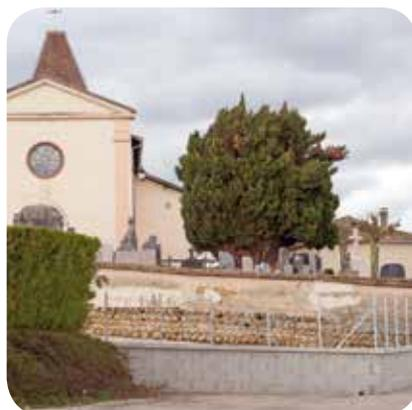
Les travaux de construction du columbarium au cimetière ont débuté par la réalisation de l'enceinte, soit un nouveau mur de clôture et la reprise du mur existant et un sous-bassement pour recevoir les cases. Le montant des travaux est d'environ 11 000 €.
