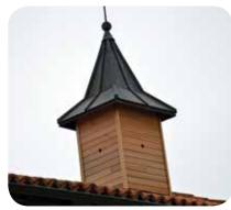
Fragilisé par des attaques de chirons, le bardage du clocheton de la chapelle a été refait en fin d'année.
