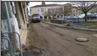
Après la tranche « rue du Tursan et haut de la place », suivra la connexion du réseau pluvial du haut de la place jusqu'au carrefour de la pharmacie, puis rues Montmartre et St Jean : pluvial, trottoirs et chaussée.
