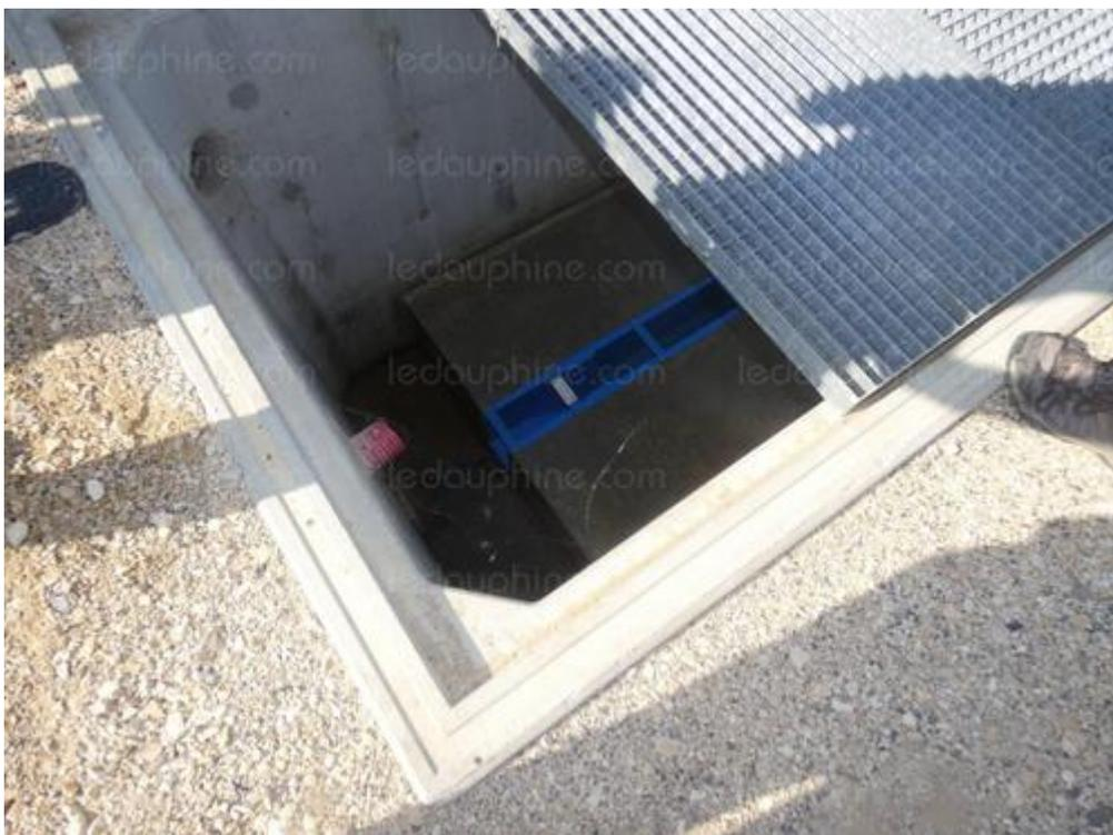
*C'est par cette installation que l'eau passe d'un bassin à l'autre lorsque l'on ouvre les vannes. Photo Le DL /Cedric PARTOUCHE*
