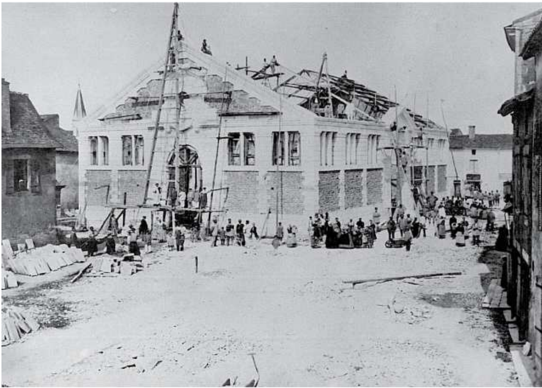
Construction des halles (1869)
