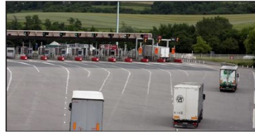
Le projet central, situé à hauteur de la barrière de péage, poursuit sa progression, a indiqué le comité de pilotage hier soir.
