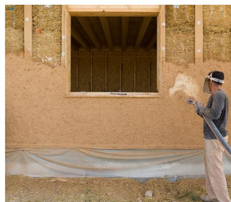
Mise en oeuvre de la paille et enduit extérieur à la chaux
