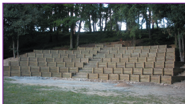
Reprise des gradins existants
