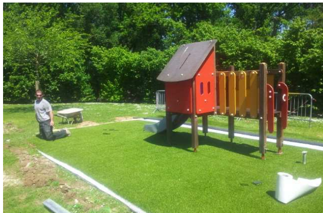
Les jeux des petits près de la salle des fêtes ont pris de la couleur et de la douceur grâce à la pose de gazon synthétique sur un amortisseur
