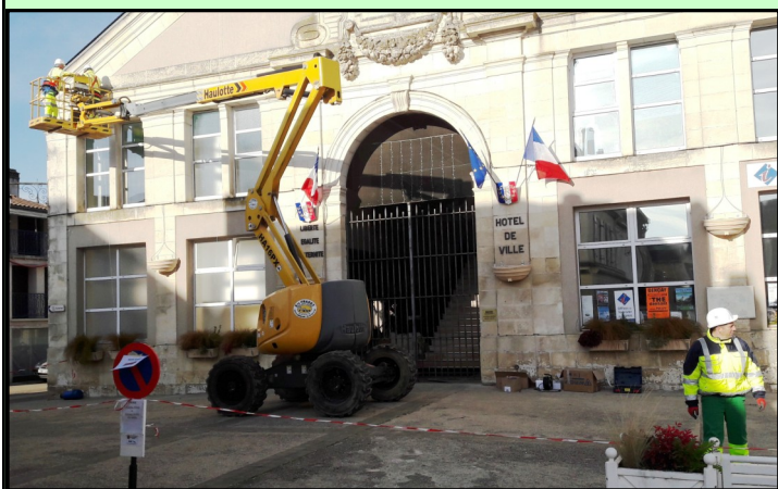
Pose des guirlandes de Noël sur le fronton de la mairie Nos agents ont été formés cette année pour utiliser une nacelle.
