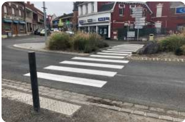
Remise à neuf du marquage au sol
