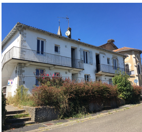
Une verrue en cours de réhabilitation
