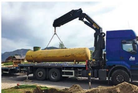
EXTRACTION DE LA CUVE À GAZ
