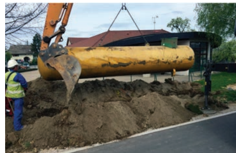
EXTRACTION DE LA CUVE À GAZ
