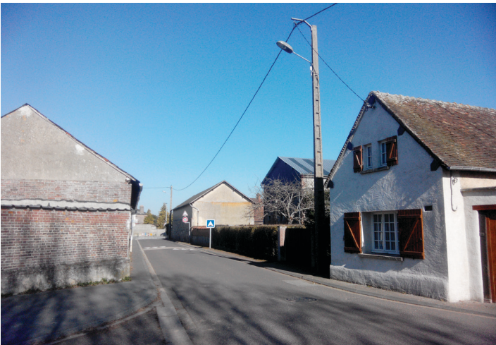
« Enfouissement des réseaux » Rue d'Osmoy
