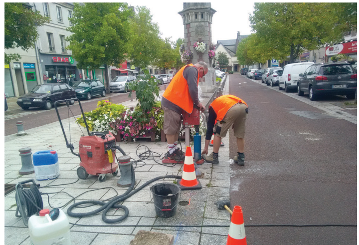
« Pose de barrières pour sécuriser le centre-ville »
