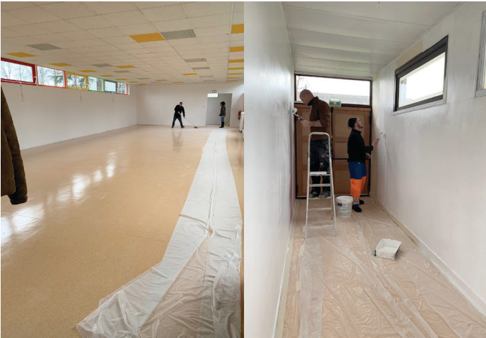
« Aménagement du centre de loisirs » avant
