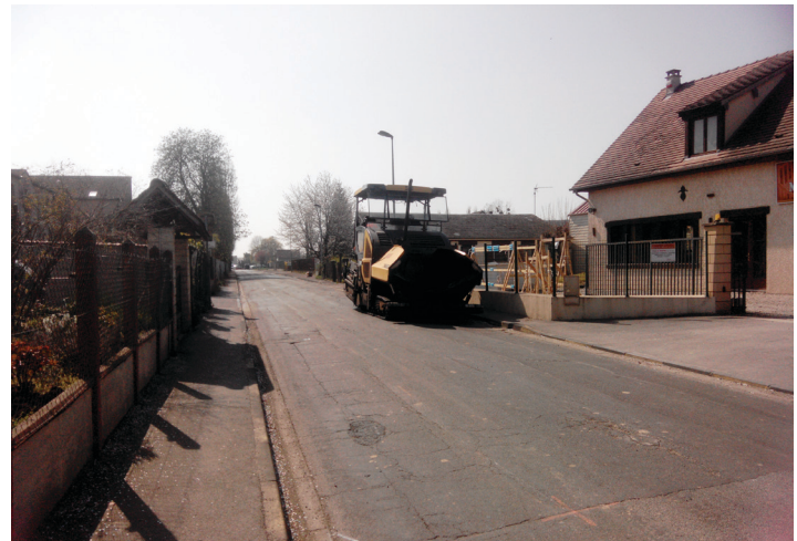
« Réfection de voirie par le Département » Rue des Épinoches
