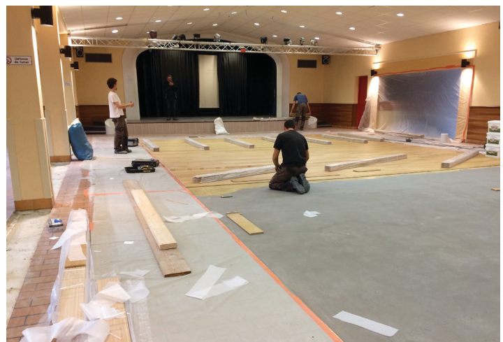
« Remplacement du parquet » Salle du Clos Mulot
