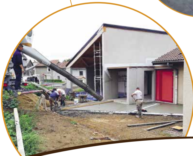
Réalisation des dalles extérieures
