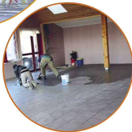
Pose du carrelage
