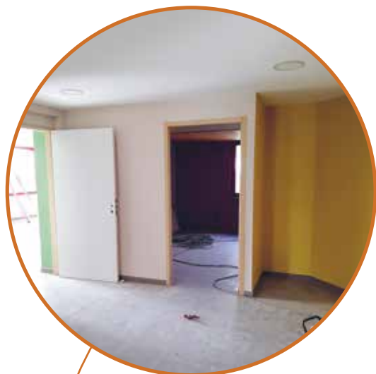
Pose de toiles de verre et peintures des murs
