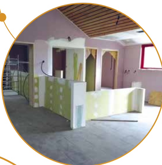
Armature du futur bar en placoplâtre
