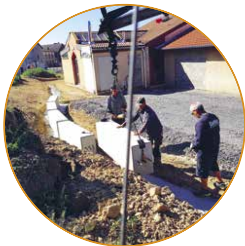
Banc extérieur en béton
