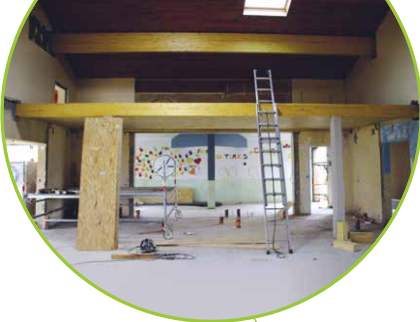
Plancher du local technique au-dessus des toilettes, destiné à l'installation de la CTA (Centrale de Traitement d'Air)
