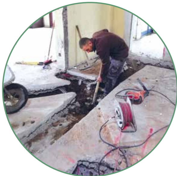
Tranchées à l'intérieur du bâtiment pour les réseaux d'évacuation
