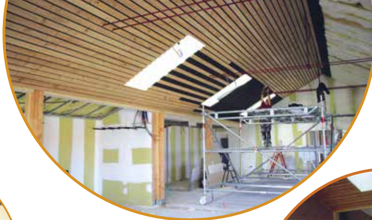
Bandes à joints et couches d'impression, plafond rampant en bois de douglas
