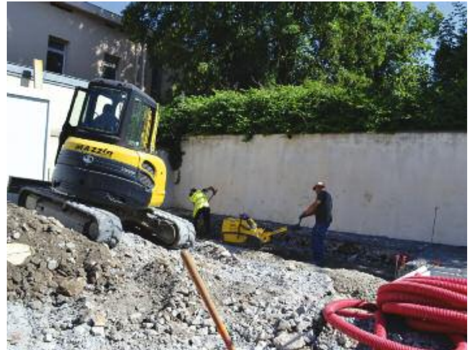
Réalisation des fondations du Nœud de Raccordement Optique rue Philippe de Gueldre à Pont-à-Mousson : c'est à partir de là que seront alimentées les 8 723 prises de la ville.
