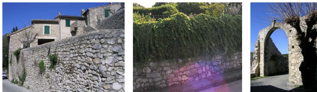
Exemples de mur de façade, accompagnement végétal, arche...
