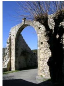
Exemples de mur de façade, accompagnement végétal, arche...
