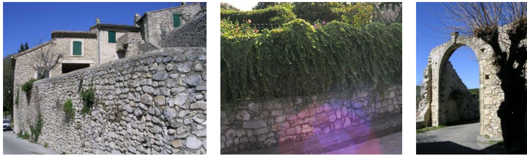
Exemples de mur de façade, accompagnement végétal, arche...
