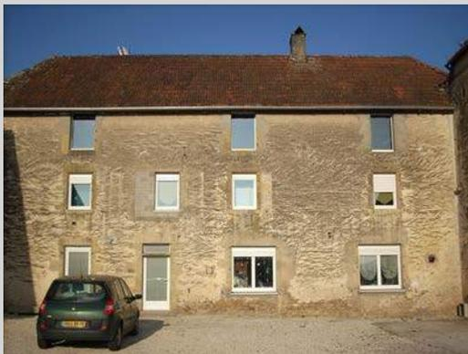
La lecture de la façade est brouillée par le mauvais découpage des menuiseries PVC. La façade souffre également de l'absence des volets en bois, remplacés par des volets
