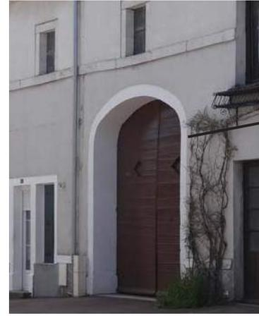
Les voussures sont généralement en pierres sur champ recouvertes uniformément par l'enduit de la façade et marquées par un jeu de texture ou/et de badigeon. Si l'appareil de pierre est sans intérêt, la protection de la maçonnerie est nécessaire.
