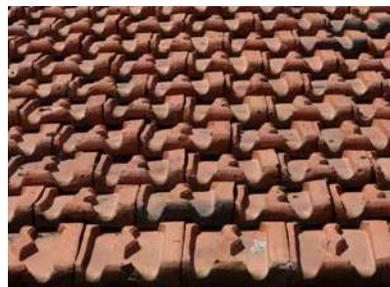
Aujourd'hui, l'utilisation de la lave a presque disparu sur SAULX. La tuile mécanique s'est largement substituée à la tuile plate.
