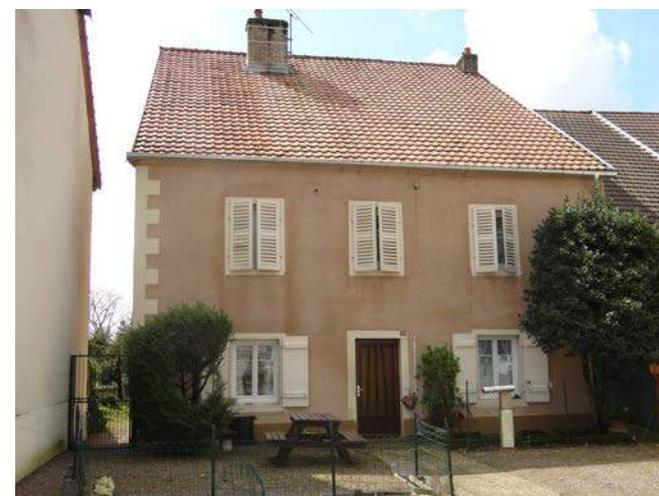
Chainage d'angle en harmonie avec les encadrements de fenêtre.
