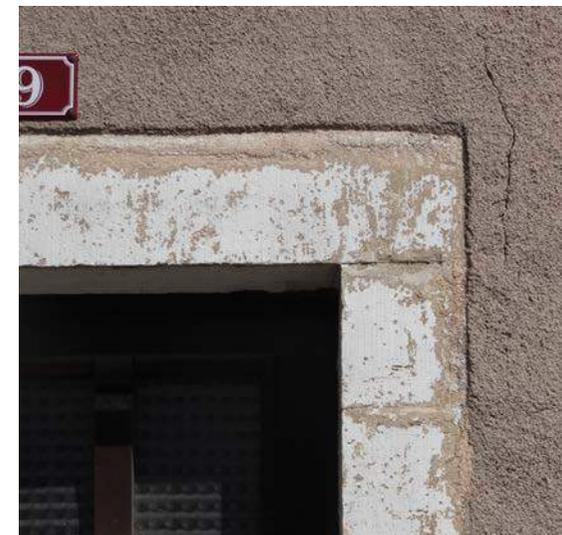
Protection de la pierre par badigeon à la chaux sur l'encadrement de fenêtre
