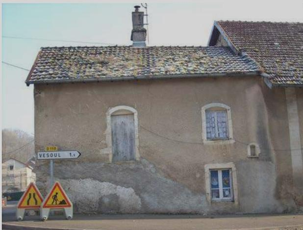
Eviter les raccords au ciment de couleur grise qui dénaturent complètement les maçonneries. Les ciments, très durs et très étanches, piègent l'humidité qui ne pourra pas ressortir.
