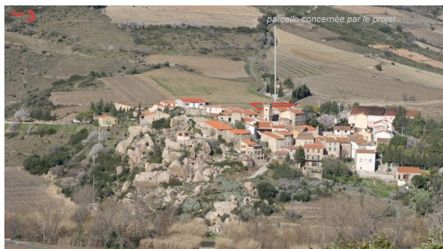
Depuis la route venant de l'Ouest, le village ancien et ses premières extensions sont complètement masquées : ce versant exposé au vent n'a pas été bâti et sert de protection naturelle aux constructions.
