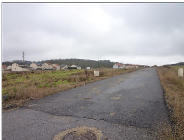
Vue de la zone d'OAP depuis le bâtiment Pôle emploi en direction de l'est
